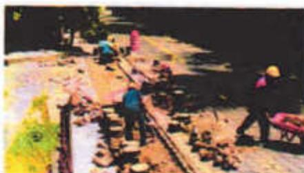
Se desarrolló un total de 53.71 m<sup>3</sup>, en la que se realizó compra de cemento según la siguiente fórmula:  $53.71 \text{ m}^3 \times 0.05 \text{ (porcentaje)} = 2.69 / 0.028$  (cantidad de bolsa utilizada por m<sup>3</sup>) = 95 bolsas de cemento.
