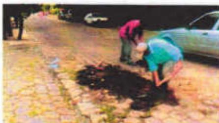
Tramo en que se realizó sustitución de suelo, debido a estado putrefacto de la base, espesores que alcanzaron hasta 0.40 metros-
