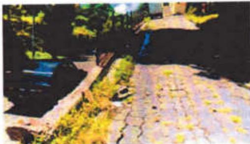
En este pasaje se utilizó tierra para compactación y colocación de adoquines, debido a que existía filtración de aguas grises y lluvias. Este pasaje no estaba incluido en el presupuesto, pero existía la necesidad de repararlo, pues era tanta la filtración de agua que estaba dañándose el muro de mampostería de piedra.
