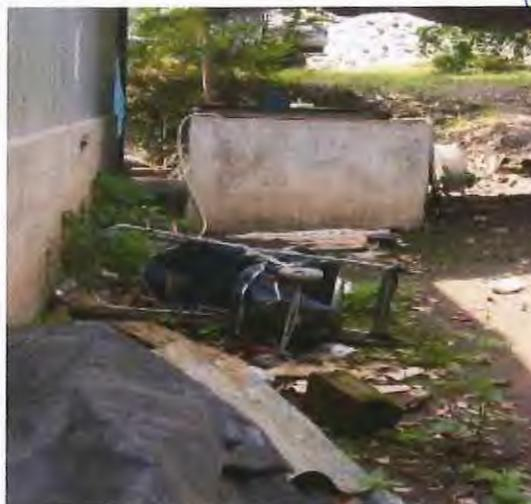
Pila de almacenamiento de agua con lama, tapaderas que permiten filtración y contaminación, alrededores de ésta se ubican desechos especiales.
