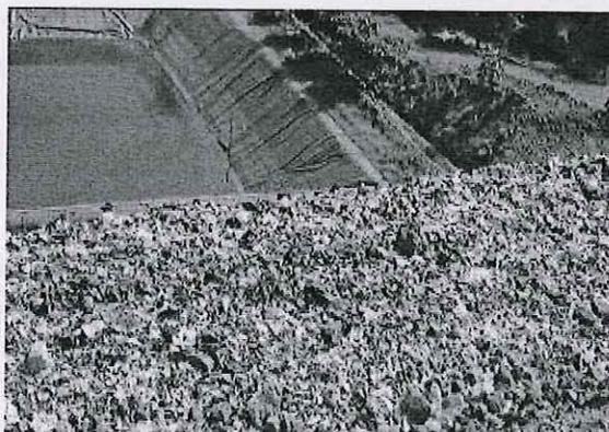
Imagen muestra desechos sólidos no cubiertos en los taludes del área 1A, que dejó de disponerse desde el 13 de julio de 2018.
