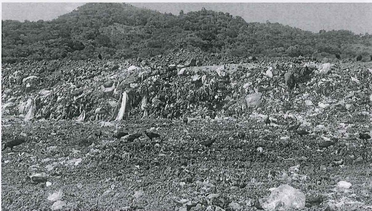
Imagen tomada el 25/07/2018 de la parte superior de la celda 1 A, observándose los desechos no cubiertos.
