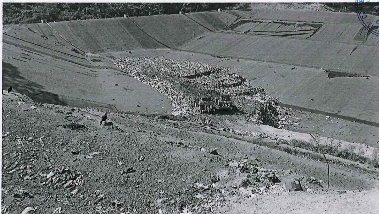
Imagen tomada el 25/07/2018, de la celda 1 B, en la cual se observa la falta de cobertura en las trincheras.
