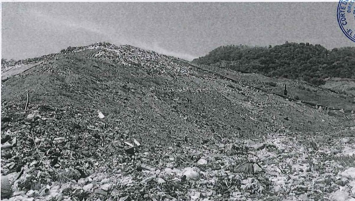
Imagen tomada el 25/07/2018, de la parte superior y zona poniente de la Celda 1 A, donde se muestran los desechos no cubiertos.
