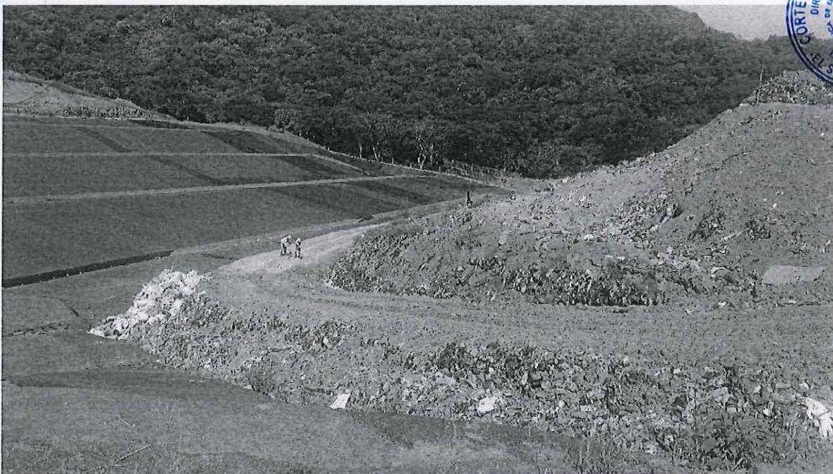
Imagen tomada el 25/07/2018 del Costado suroriente de la celda 1 A, se observan los desechos expuestos sobre la superficie y no cubiertos.
