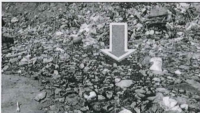
Imagen muestra lixiviados acumulados en la parte del talud del área 1 A, que dejó de disponerse desechos sólidos desde el 13 de julio de 2018; situación que se debe a la falta de drenaje o conducción de los mismos a la laguna de lixiviados; en esta se observa que los desechos sólidos flotan sobre los lixiviados.
