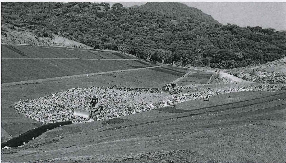
Imagen tomada el 25/07/2018, de la celda 1 B, donde se observa a la izquierda de la celda, las trincheras utilizadas desde el 13 de julio de 2018, sin la cobertura de tierra y con presencia de aves de rapiña
