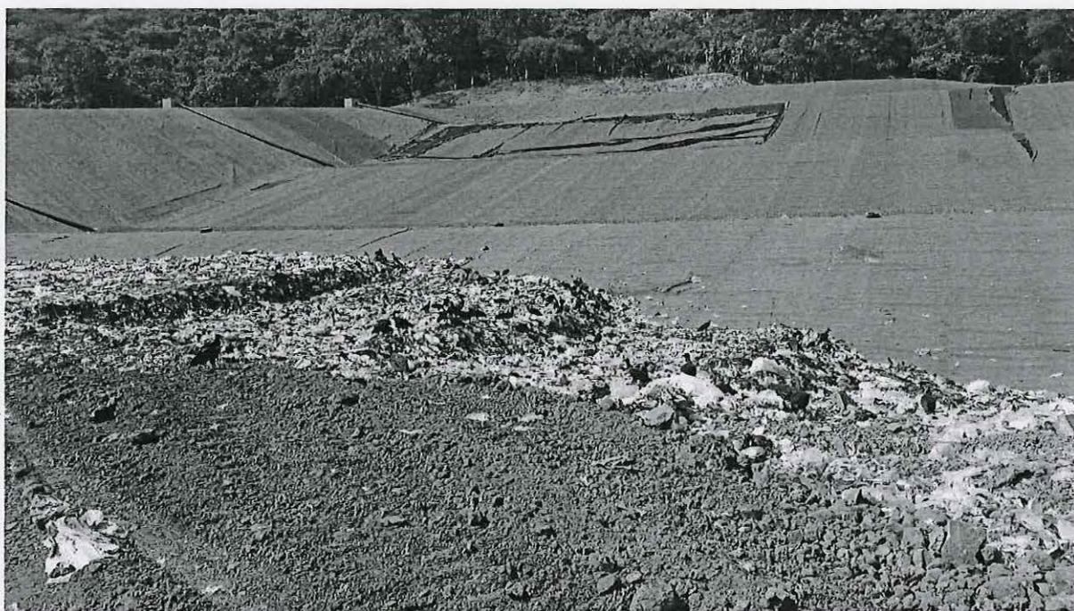
Imagen tomada el 25/07/2018, de la celda 1 B, en la que se ve la presencia de aves de rapiña por la falta de cobertura de los desechos en las trincheras.
