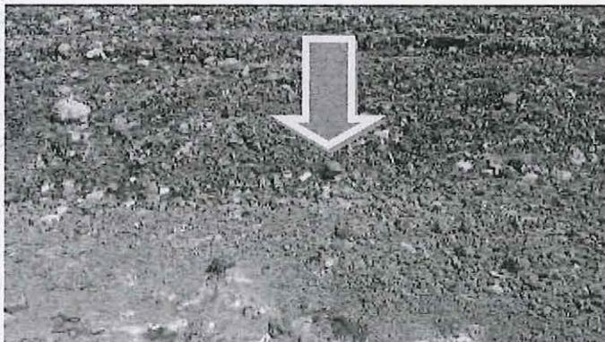
Imagen muestra lixiviados acumulados en la parte superior del área 1 A, que dejó de disponerse desechos sólidos desde el 13 de julio de 2018; situación que se debe a la falta de drenaje o conducción de los mismos a la laguna de lixiviados.
