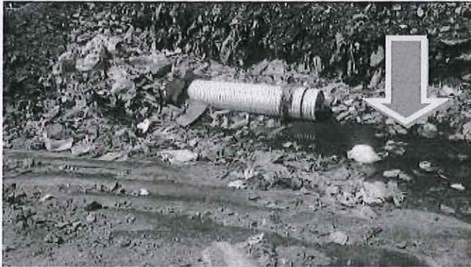
Imagen muestra lixiviados acumulados en la parte del talud de área 1 A, que dejó de disponerse desechos sólidos desde el 13 de julio de 2018; situación que se debe a la falta de drenaje o conducción de los mismos a la laguna de lixiviados; en este se observa el tubo que descarga los lixiviados sobre el mismo talud y no los conduce a la laguna.
