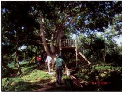
Estructura de madera en árbol, sin condiciones de seguridad para ser utilizada
